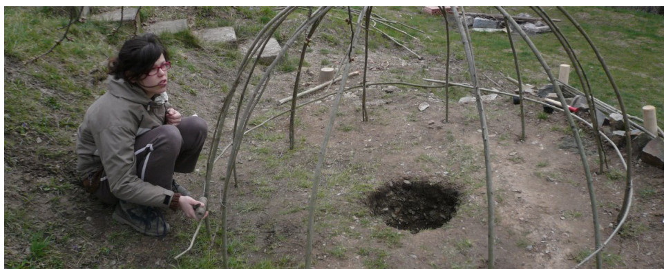
Obr. 25. Přivazování příčných obručí
