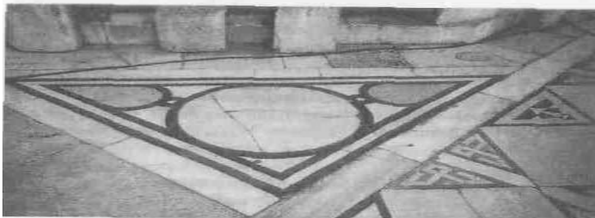
Obr. 35: Detail podlahových desek v mešitě sultána Hasana
