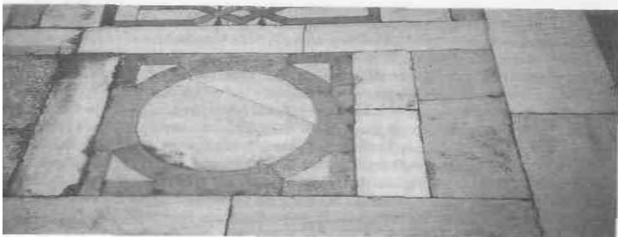
Obr. 36: Detail podlahových desek v mešitě sultána Hasana
