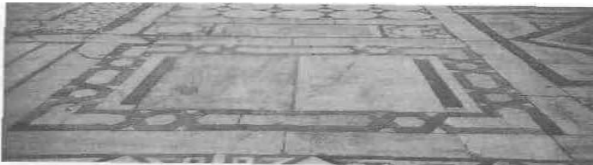
Obr. 34: Detail podlahových desek v mešitě sultána Hasana
