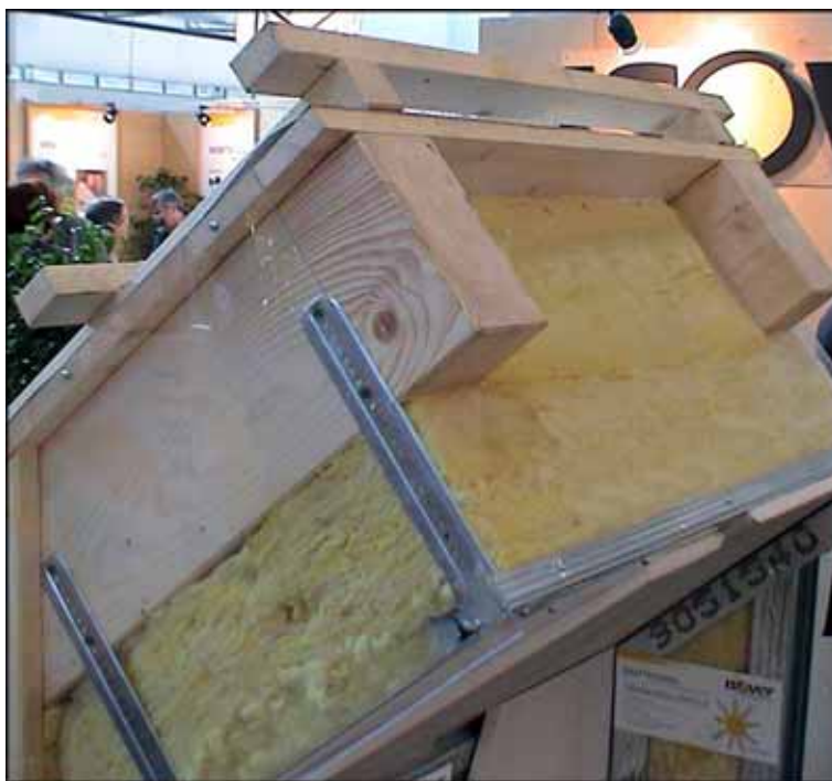
Obrázek č. 2 – Ukázka správného uložení tepelné izolace střechy.
