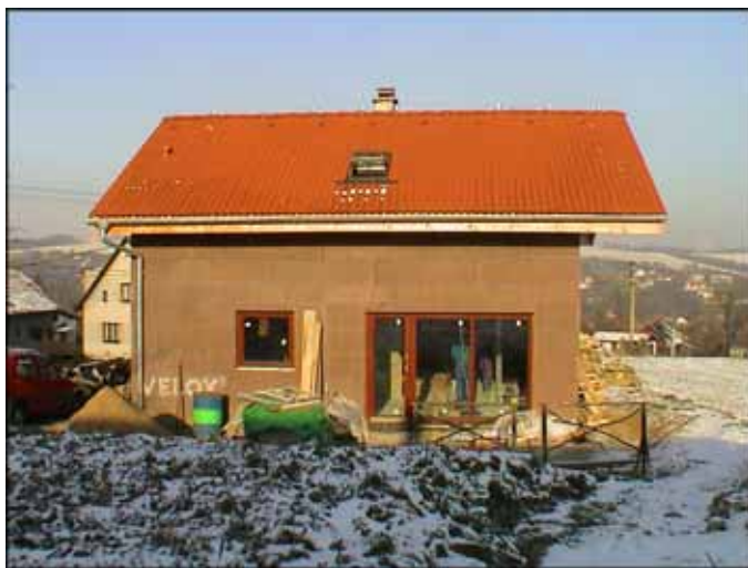
Obrázek č. 35 – Budování demonstračního nízkoenergetického domu.
