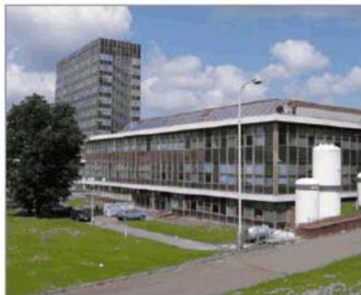
Střešní instalace na Karlově univerzitě v Praze.
