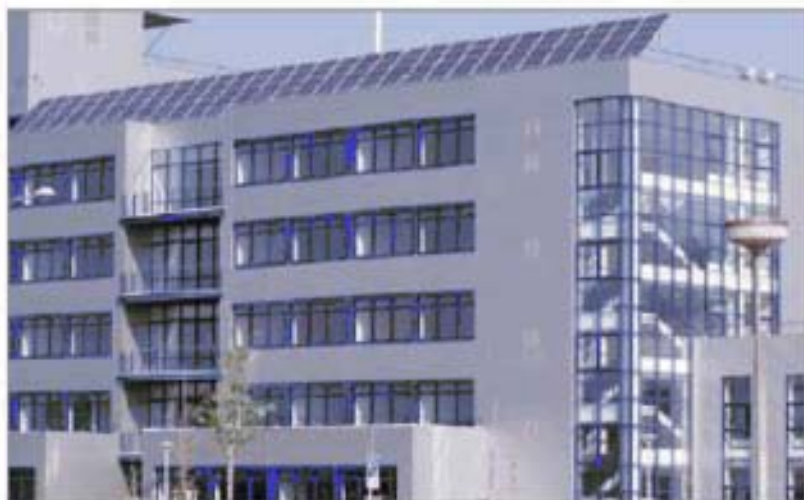
Střešní instalace na Západočeské univerzitě v Plzni.
