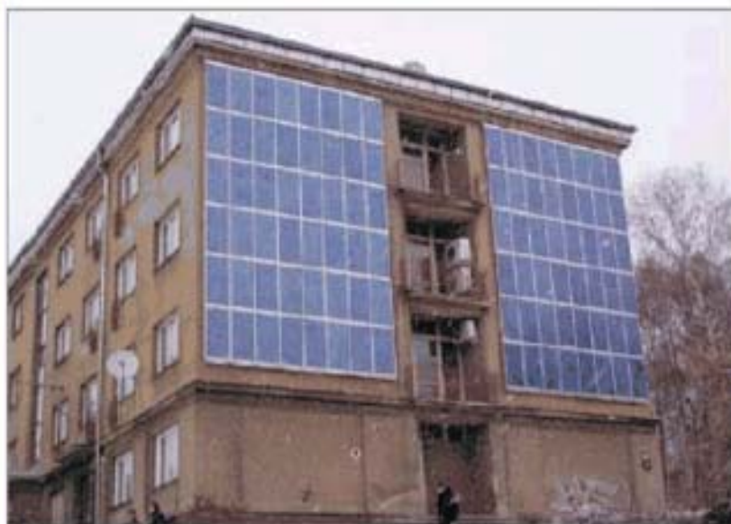
Fasádní instalace na Technické univerzitě v Liberci.
