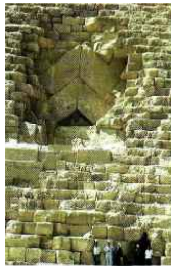
Hore: Vchod do impozantnej pyramídy s prekladom nad dverami, ktorý je v porovnaní s otvorom dverí predimenzovaný.
