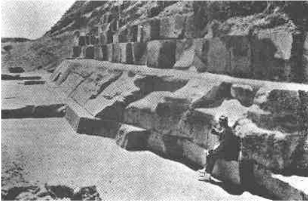
Obrázek 3.7 – Obkladové kameny, které stále existují podél základního obvodu Velké pyramidy.
