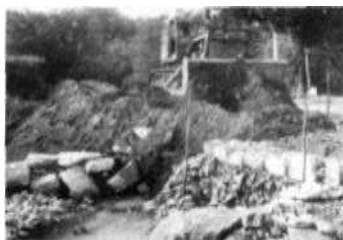
Buldozér zakrýva základy údajného Pribinovho kostola.
