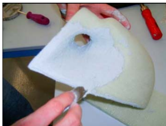
Obr. 5: Povrchové úpravy – nanášanie tmelu [2]
